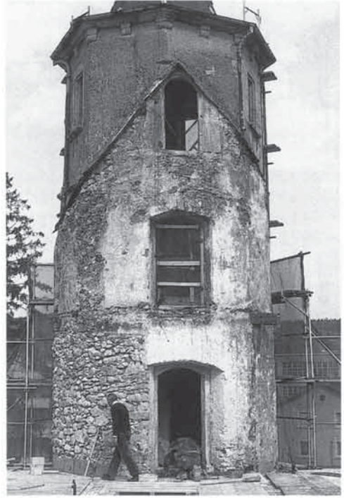
50 Der nach innen freigelegte Turm
