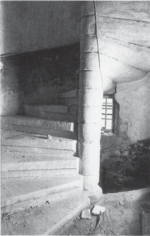
8 Wendeltreppe im Erdgeschoss (1985)
