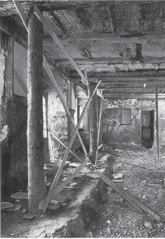
49 Abgestützte Südwestecke im Erdgeschoss
