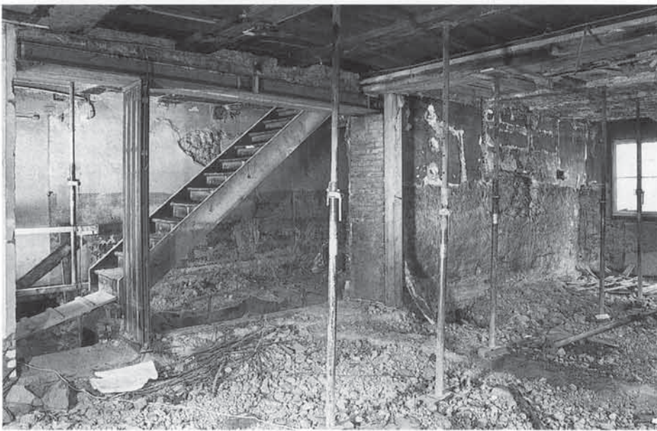
51 Nordostteil der einstigen vordern Wirtschaft mit damaliger Treppe im Gang
