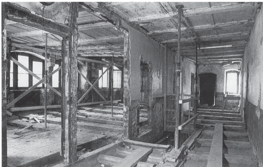
52 Grosser Saal und Gang im 1. Stock; die ursprüngliche Decke ist freigelegt
