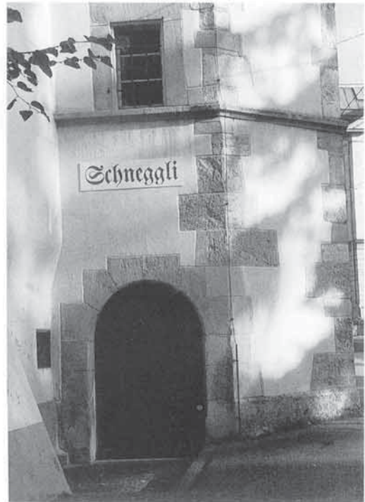
26 Eingang in den Schneggli-Turm (1988)
