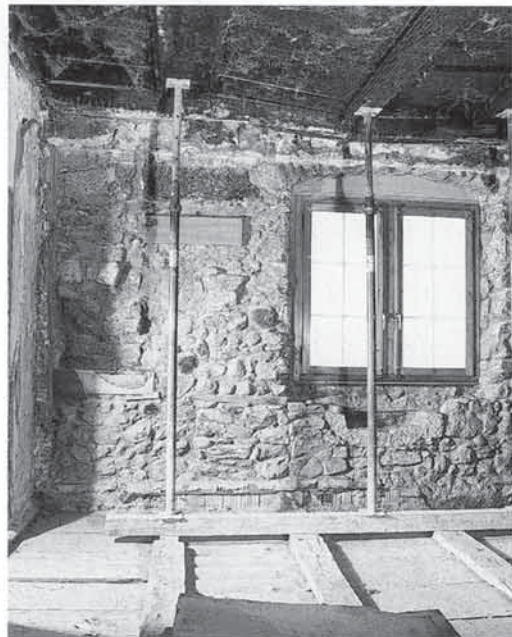
54 Ursprüngliche Küche im ältesten Gebäudeteil
