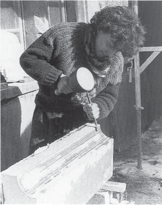
55 Steinmetz bearbeitet Fenstereinfassung
